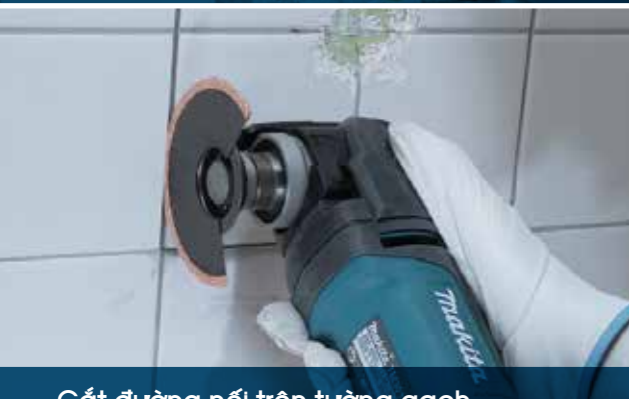
Cắt đường nối trên tường gạch
