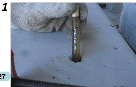
Lắp đặt bằng cách dùng búa đóng lên con tán
